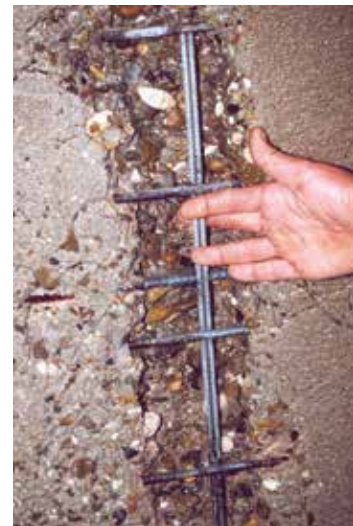
Faible vitesse (1000 tr/min) pour hydrodémolition de béton ou surfacage
